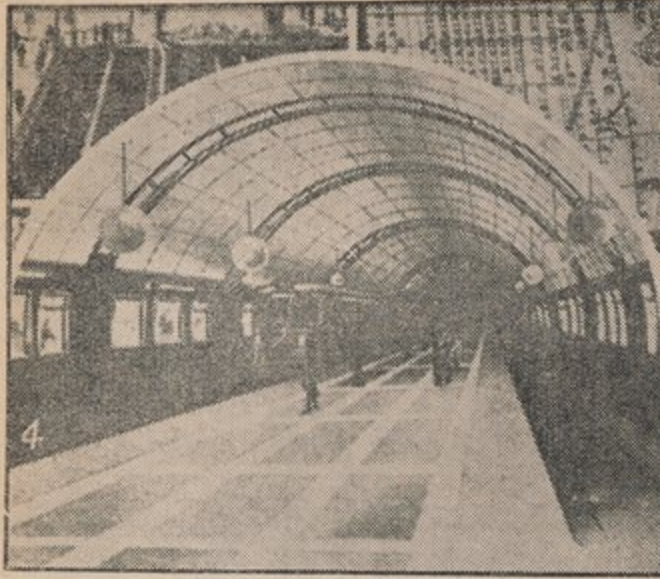
( شكل ٨٨ ) سكة حديد الكهرباء التي تسير تحت الأرض في أوزاكا
