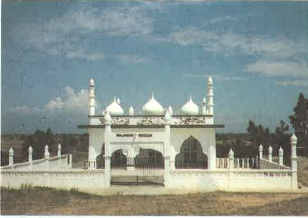
مسجد ميفانبا في منطقة للمسلمين في الريف خارج مدينة نادي
