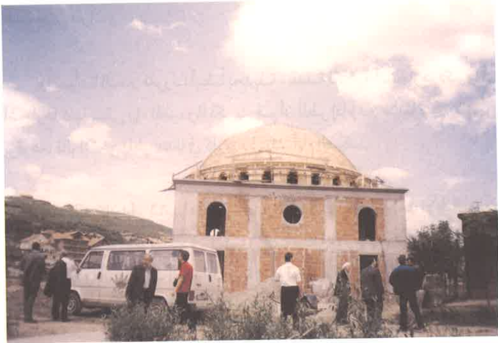
مسجد ستوفالي (تحت الإنشاء) في بريشتنا
