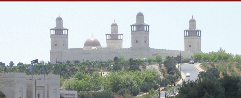
Kong Husseins Moské, Amman, Jordan: blev indviet i 2005 som en af de største moskéer i Amman, som afspejler den moderne islamiske kunst og kalligrafi. Med sin firkantede form og fire minareter tårner den op over byen Amman, da den er bygget på en høj ca. 1000 meter over havoverfladen.
